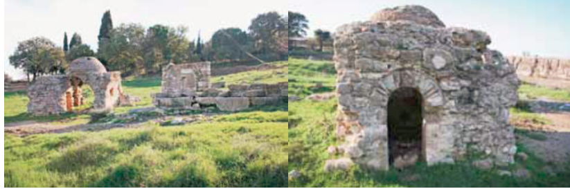
Şekil 4. Özbek Köyü Hamamı ve Çeşmesi.
